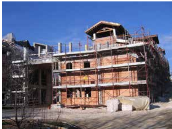
Laterizi per costruire case massive standard di PassivHouse
