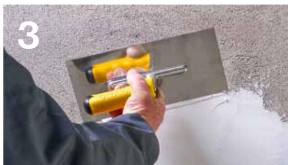
Una volta pronto stendere il composto con una spatola americana da parquet (con "denti" da 2 mm). Il Bronya Facade va steso con uno spessore tra 1 e 1,5 mm con una sola passata. Il Bronya Light va steso con uno spessore tra 3 e 4 mm con una sola passata.
