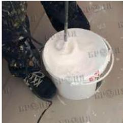
Tempo di miscelazione approssimativo - Mixer 3-8 minuti, miscelazione manuale 7-10 minuti. Se il compito è rimuovere la condensa, il gelo, funghi e muffa il materiale viene applicato con un'aggiunta minima di acqua e un periodo massimo di essiccazione di ogni strato (oltre 24 ore).
