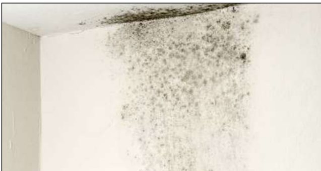
Figura: Angolo con formazione di muffa
